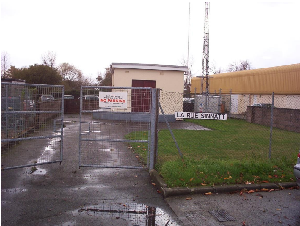
Photo B1.7.1 : Rue Des Pres above ground structure
